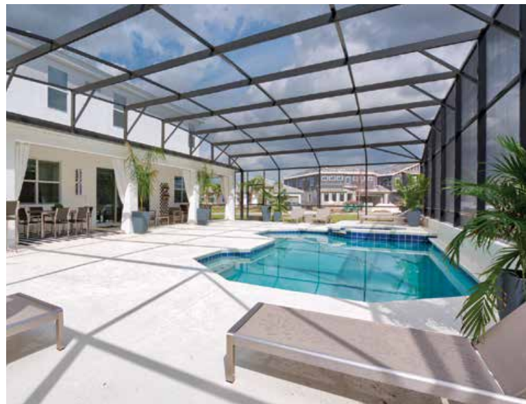
À ESQUERDA E ACIMA, AS DIFERENCIADAS INSTALAÇÕES DAS CASAS VHC ON THE LEFT AND ABOVE, SPECIAL FACILITIES OF VHC HOUSES
